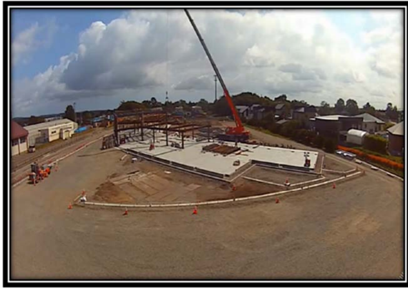
現場のライブ映像：鉄骨建て方時
